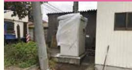
クレーンで搬入し、新しく土台工事をした上に設置します
