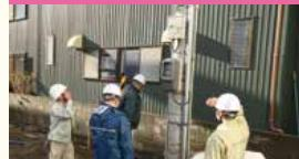
電柱に計器類を設置し、新しいキューピクルが問題なく作動するか確認します
