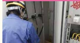
新しいキューピクルをケーブルに接続後、電力会社の電線と接続
